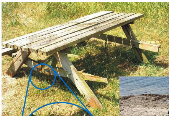
Bænken er knækket helt af. Konstruktionen er knækket.
